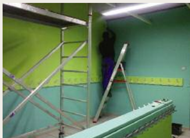
Travaux de peinture à l'école maternelle
