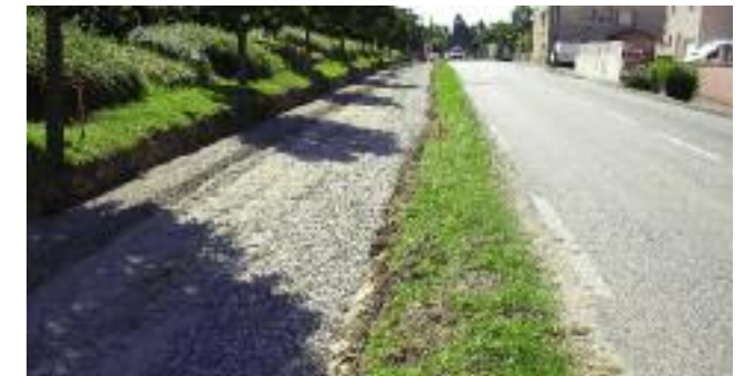
Aménagement des pistes cyclables - avant après Travaux financés par la CCCB
