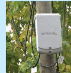
**Sous répartiteur optique (SRO) qui distribue en moyenne 400 foyers.** Liaison avec câble fibre optique vers les points de branchement des usagers (PBO) extérieurs sur poteaux ou souterrains dans les regards sous trottoirs.
